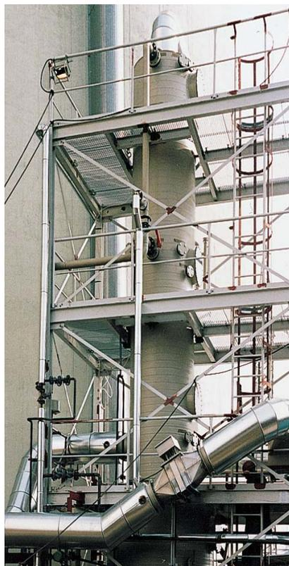
*Füllkörperwäscher zur SO<sub>2</sub>-Abscheidung für 6.000 Nm<sup>3</sup>/h*
