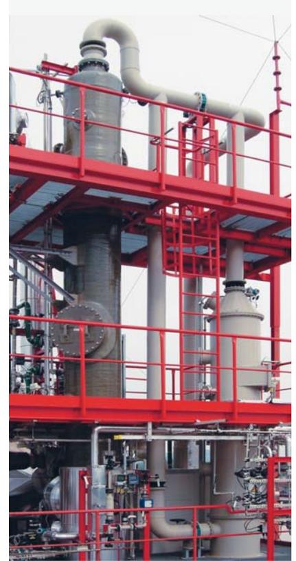
Absorber mit elektrostatischem Aerosolabscheider (Durchsatz 2.500 Nm<sup>3</sup>/h)
